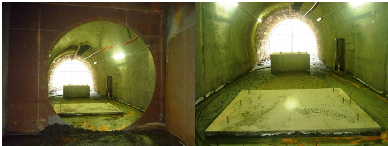
Ilustración 3: Condición Inicial de Base para Extractor en Bocamina Nv 0.
