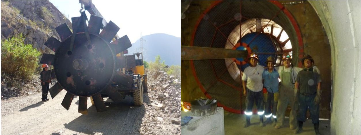
Ilustración 4: Traslado e Instalación de Ventilador en Bocamina Nv 0.
