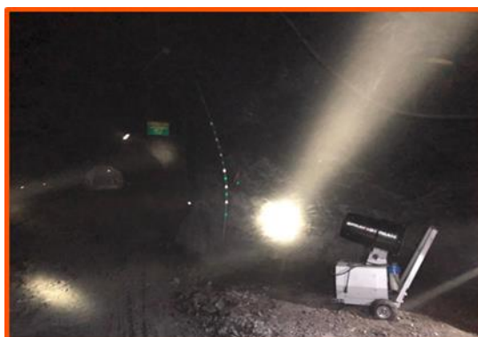
Ilustración 5: Implementación de Cañón nebulizador en el piso.
