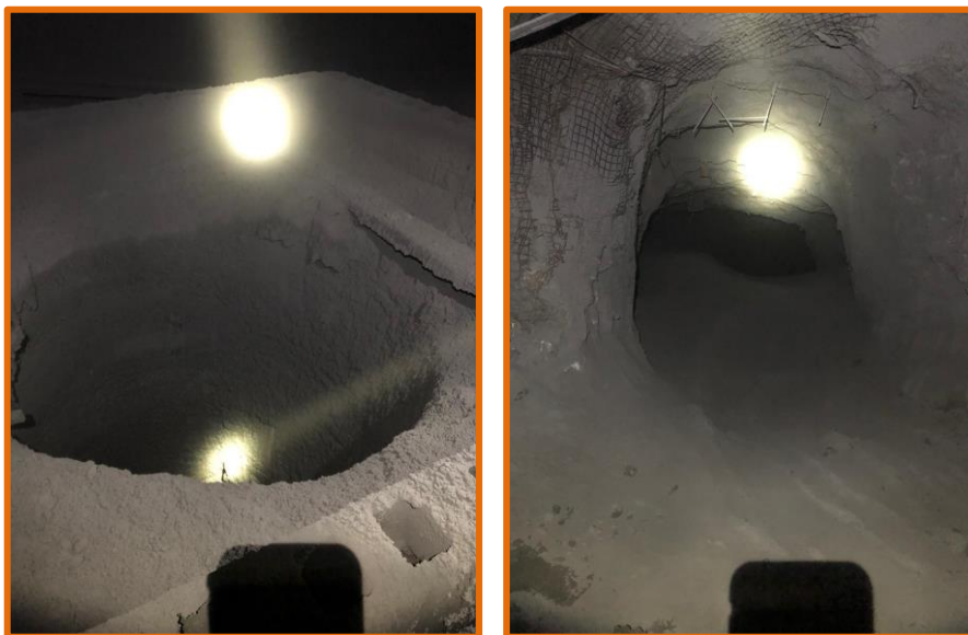
Ilustración 20: Acumulación de material particulado en el pie y la cabeza del proyecto "Aspiradora".
