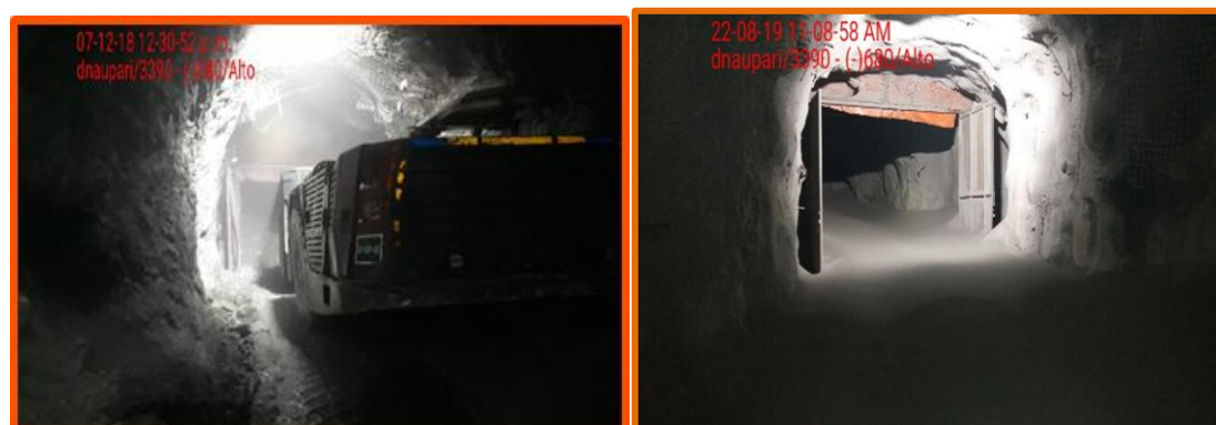
Ilustración 14: Puertas afectadas por equipos (izquierda) o por fin de operación (derecha).
