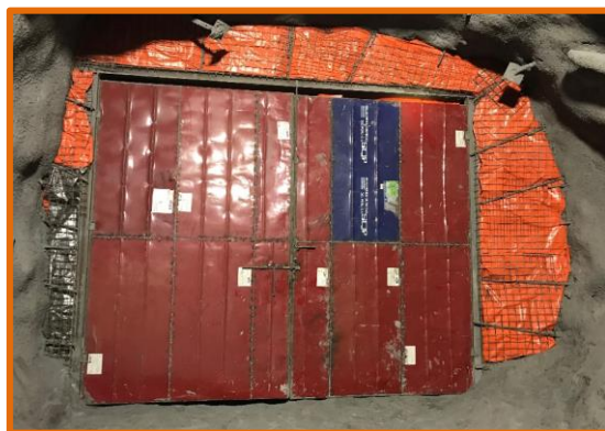
Ilustración 7: Implementación de Compuerta para restringir el efecto pistón.
