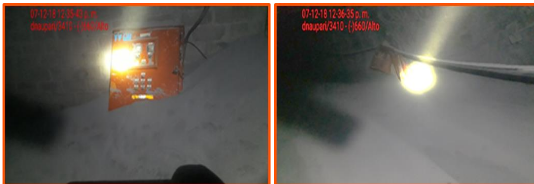
Ilustración 17: Elevada acumulación de material particulado en los niveles de acumulación.
