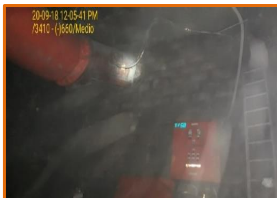
Ilustración 8: Implementación de extractor local con evacuación a través de ducto.
